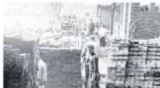
STAVBA SOKOLOVNY v Dřemčovicích Foto: archiv Sokolů
