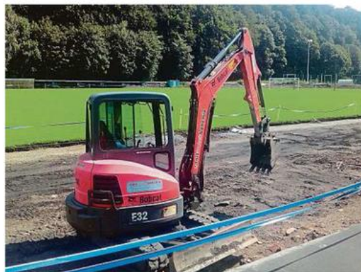
Na stadionu ve Velkých Hamrech zařadily bagry. Vrcholí tam práce na obnově atletické dráhy. Nový povrch bude špičkový.
