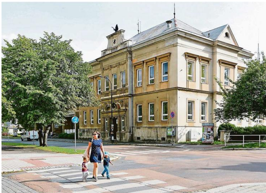
Nová podoba vzejde ze soutěže Rokycanská sokolovna je už tři roky zavřená. Odborníci našli v krovech a ve stropě dřevomorku. Zastupitelé včera schválili, že město vypíše veřejnou architektonickou soutěž na kompletní revitalizaci stavby. Projekt vyjde na přibližně 350 milionů korun. Foto: Petr Eret, MAFRA
